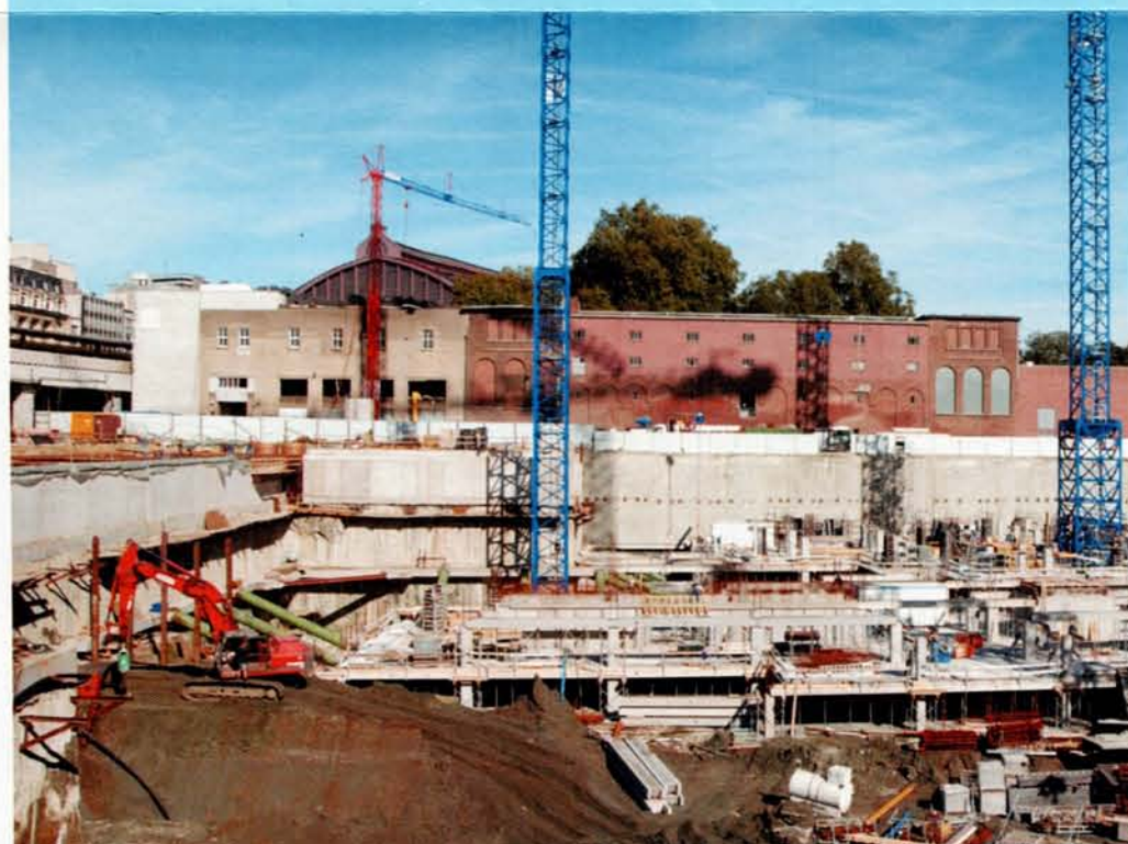
Op de werf aan het latere Kievitplein zijn de funderingen voor het gigantische gebouwencomplex en de ondergrondse parking duidelijk zichtbaar.
