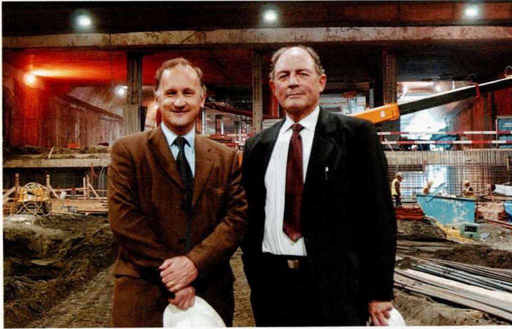
Directeur-Generaal Dirk Demuyck (l.) en projectleider Marc Christiaens (r.) van Tuc Rail bekijken trots de werken in de tunnel tussen Antwerpen-Berchem en Antwerpen-Centraal.
